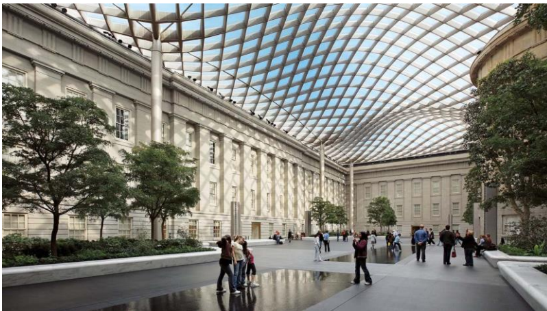
Abb. 1 Innenansicht des Daches des Hofes. Zeigt das wellenförmige Netz der Hülle
