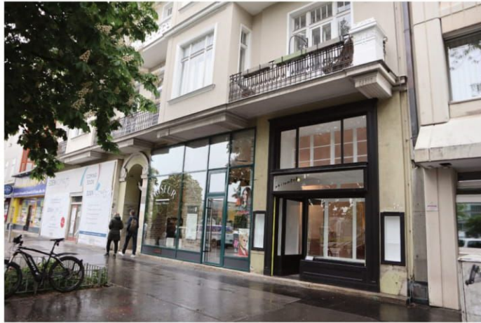
Heinstraße 40, Wien 1020, nachdem Sanierung
