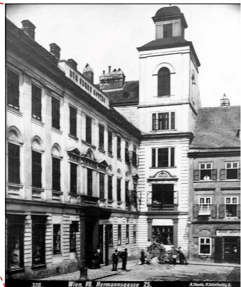
Abbild 7: Ein Bild vom Haus aus dem Jahr 1883, wo man den Turm und die ursprüngliche Fassadenelemente sieht.
